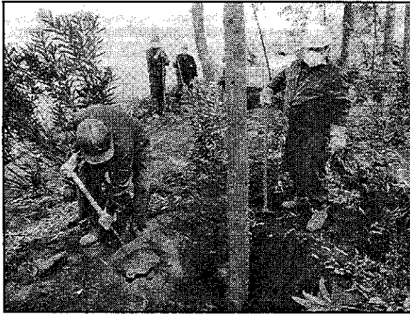
Obreros en labores de retirada de lodos.
