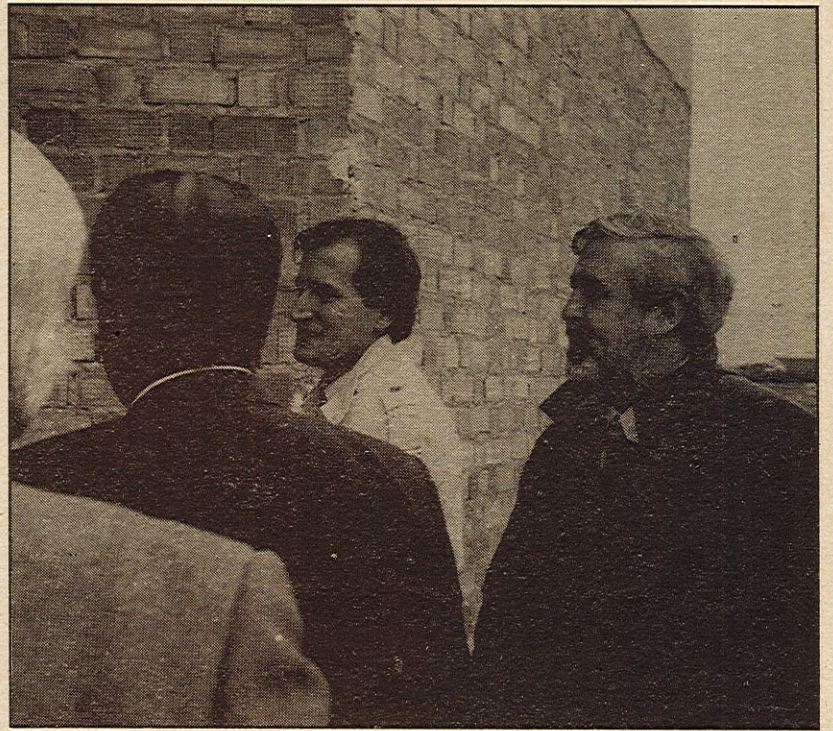
EL Gobernador Civil ante la oficina del INEM en construcción.
